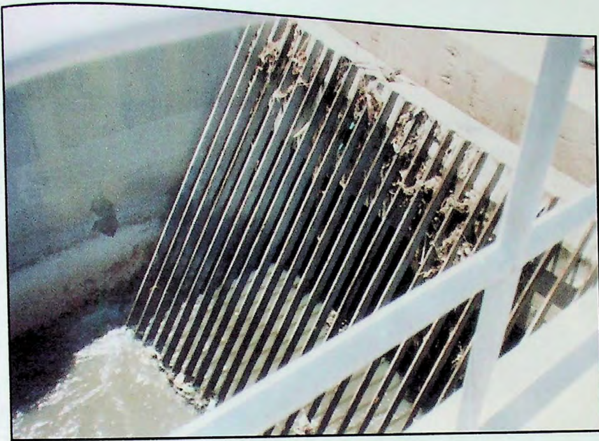
Fig. 39 : B) Coarse manual screen
