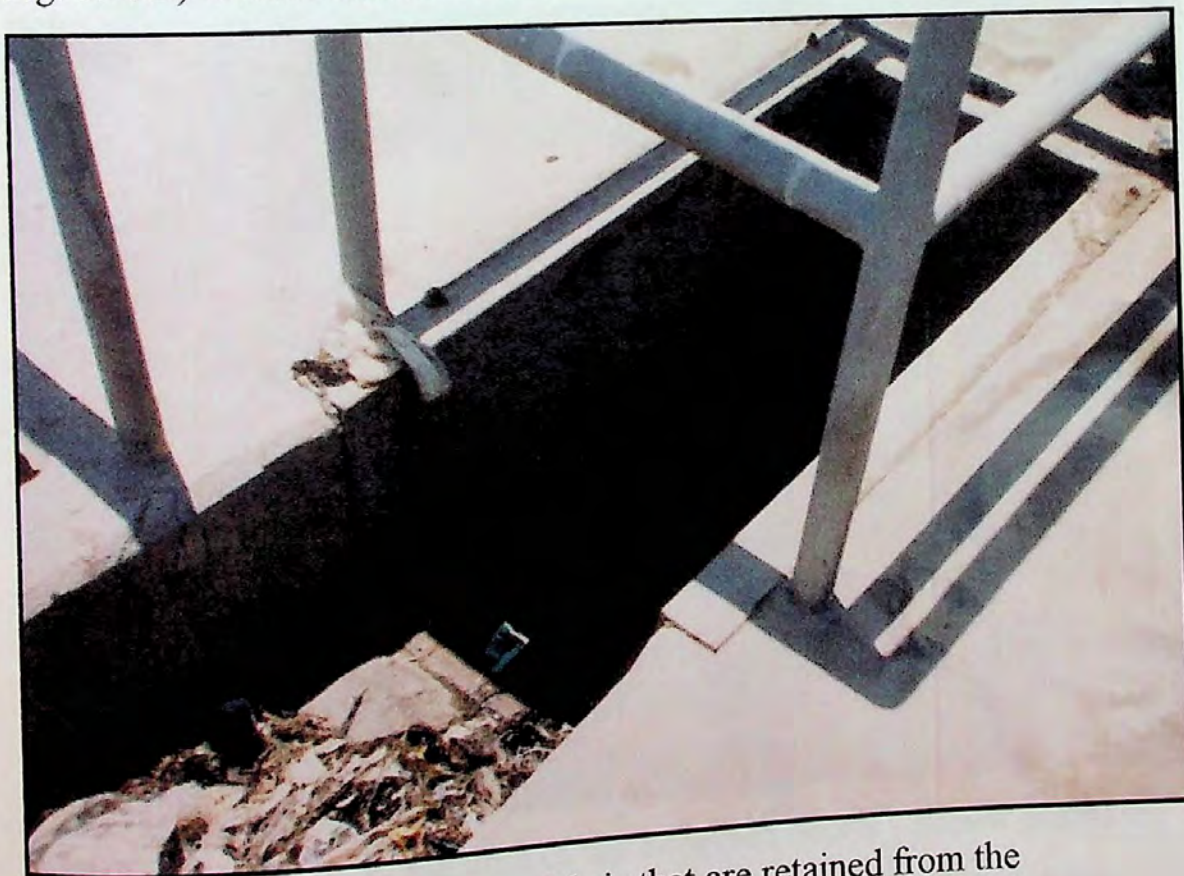
Fig. 39 : B) Coarse manual screen
